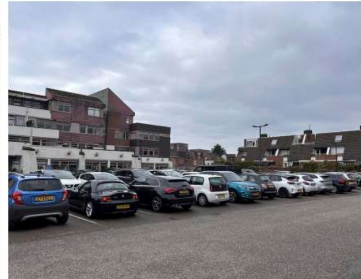
Het parkeerdek, voormalig gemeentehuis en woningen met parkeergarage zijn fysiek sterk verknoopt, en daarmee in fasering nauw met elkaar verbonden.
